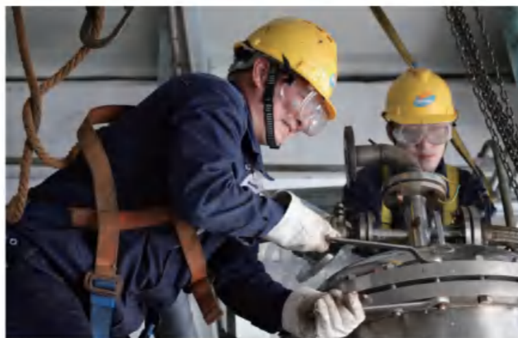
安装工人加速项目施工
